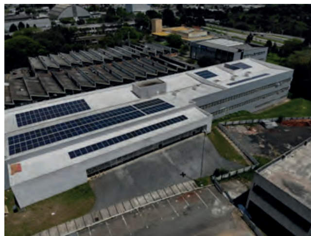
Usina no telhado do Departamento de Engenharia Química
